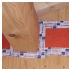
Abklebung der Bauteilanschlüsse (Bild: BV Reitham)
