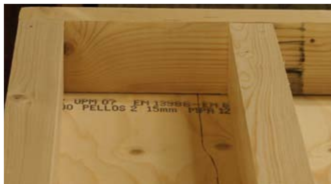
WISA-Spruce in Holzrahmenkonstruktion (Bild: Fa. Sonnleitner Holzbauwerke)
