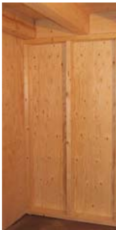
Tragende und aussteifende Innenwand mit WISA-Spruce (Bild: BV Reitham)
